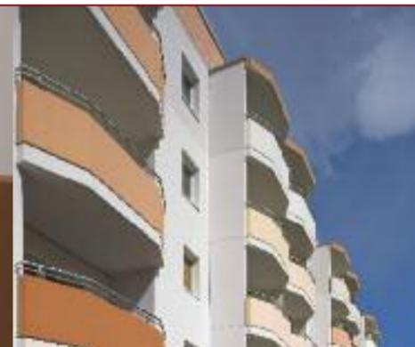
Le réaménagement des loggias et la mise en place de balustrades en aluminium de haute qualité constituait également une part importante de la réhabilitation.
