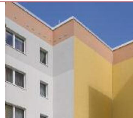
Les 15 000 m<sup>2</sup> de surface de façade ont été réhabilités avec le système d'isolation thermique par l'extérieur haut de gamme Alprotect Carbon.
